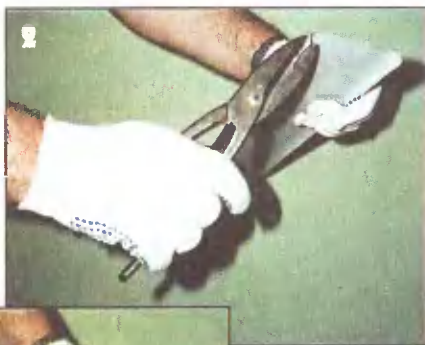
Резка ножницами по металлу потолочных панелей, П-образного профиля и окантовочного уголка.
