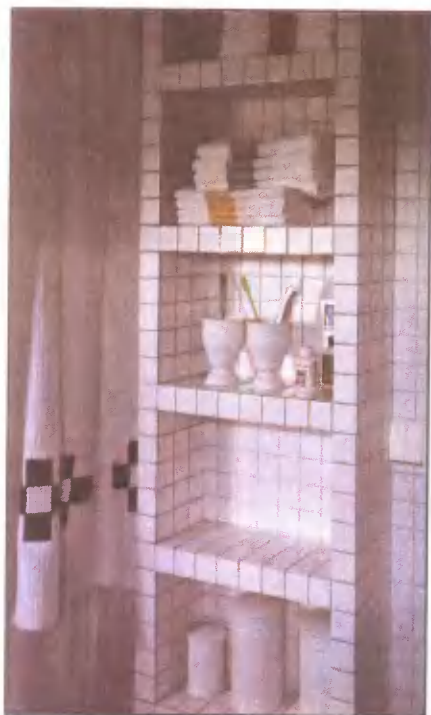
При облицовке плиткой настенной полки обратите внимание на совпадение швов!
