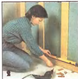
Доски обшивки не должны доходить до пола. В качестве упора к стене временно крепят полосу ДСП, выставив ее по уровню с помощью прокладок из твердой ДВП.
