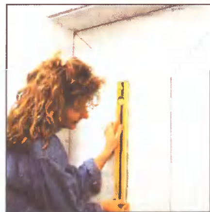
Контур окрасиваемой поверхности наносят на очищенное и обезжиренное дверное полотно.
