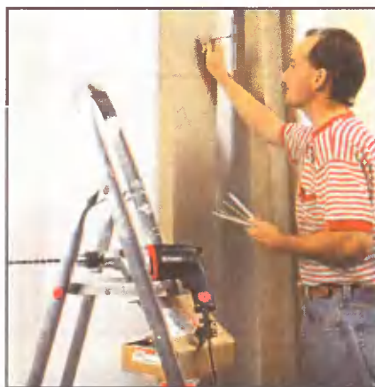
Обе П-образные «колонны» из 16 мм ДСП крепят к стене на длинных дюбелях.
