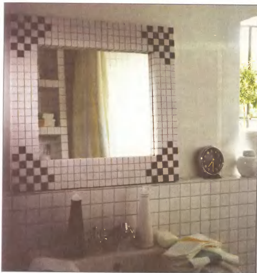
При облицовке плиткой настенной полки обратите внимание на совпадение швов!
